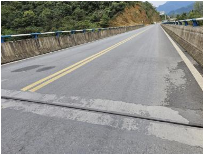
图 3.2-5 桥面现状照片
