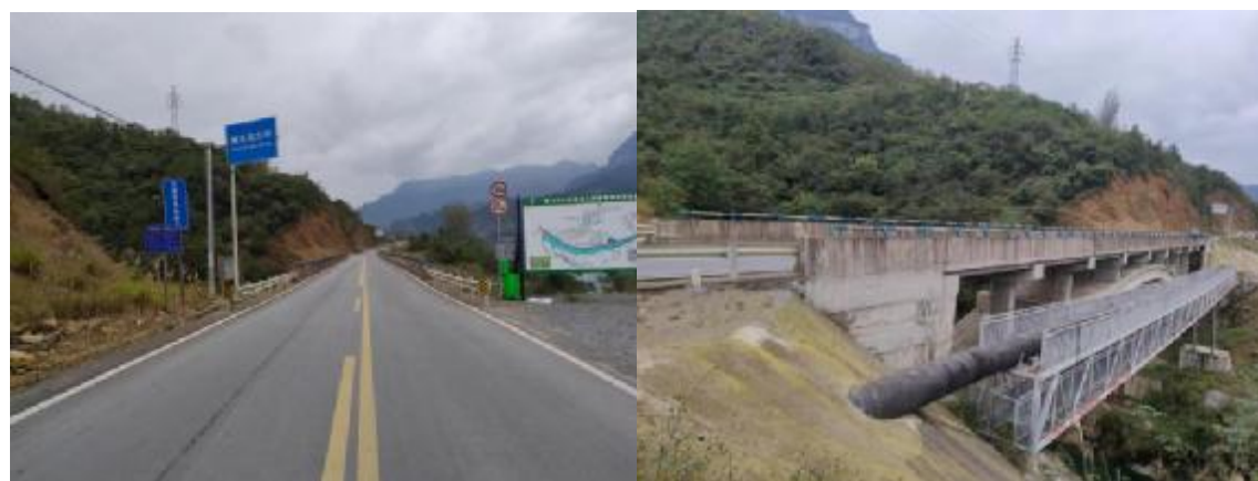
图 1.1-2 响水沟大桥现状照片
